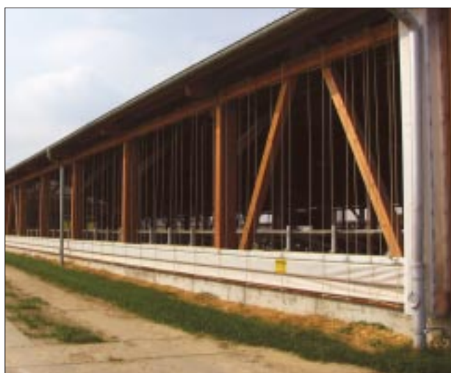
Oben: Licht, Luft und Ruhe im Stall – gute Voraussetzungen für hohe Tierleistungen. Bis 50 cm über den Boden öffnen die Seitenwände. Kleine Fotos: Sensoren zur Curtainsteuerung und automatischer Antrieb.
