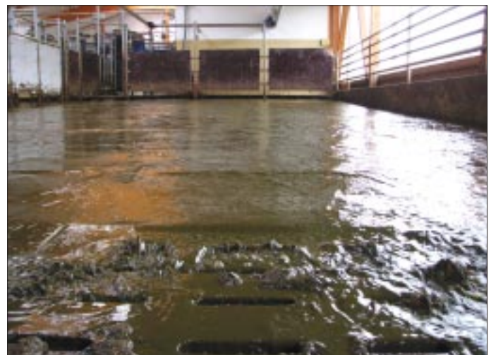
Das Gefälle des Vorwarte Hofes bewirkt, dass die Kühe mit dem Kopf zum Eingang des Melkkarussells stehen. Außerdem ermöglicht es, zur Reinigung eine „Wasserspülung“ einzusetzen. Dafür wird Wasser aus dem Melkstand gesammelt und wöchentlich erneuert.
