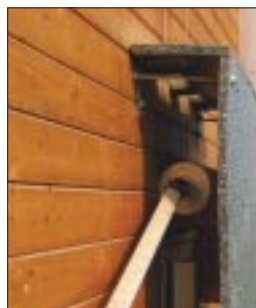
Oben: Licht, Luft und Ruhe im Stall – gute Voraussetzungen für hohe Tierleistungen. Bis 50 cm über den Boden öffnen die Seitenwände. Kleine Fotos: Sensoren zur Curtainsteuerung und automatischer Antrieb.
